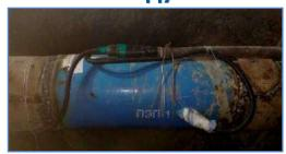
Специалисты участка контрольно-измерительных приборов, телеавтоматики и связи совместно с бригадой аварийно-восстановительных работ РЭУ «Троицкий групповой водопровод» ГУП КК «Кубаньводкомплекс» выполнили работы по монтажу устройства преобразования расхода воды на водоводе диаметром 300 мм на село Гайдук.
