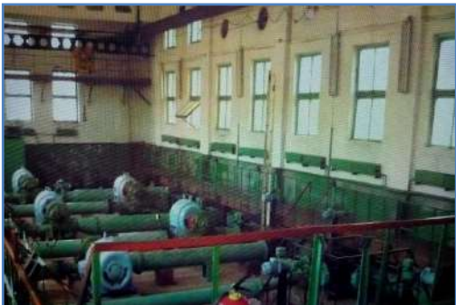
На фото: НС-3 до ремонта
