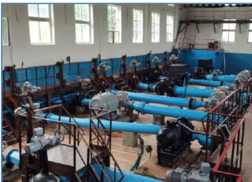
На фото: НС-3 после ремонта
