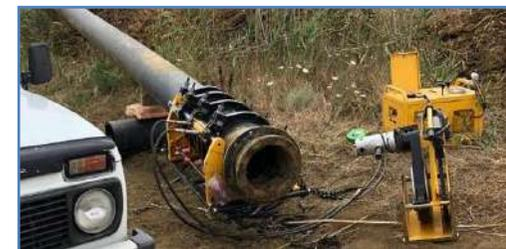
допровод» ГУП КК «Кубаньводкомплекс» заменили аварийный участок магистрального водовода В-34 протяженностью 364 метра. Работы проводились в рамках производственной программы.
