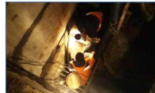
Специалисты заменили четыре метра поврежденных труб и заменили две задвижки диаметром 150 мм. В ремонтных работах было задействовано две бригады АВР, четыре единицы спецтехники. Работы были завершены к полуночи. После чего, магистраль была промыта. Взятые пробы воды не показали каких-либо отклонений от норм СанПиНа. Магистральный водопровод МВ-2 был введен в штатный режим работы.
