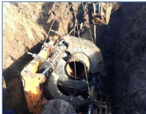
Серьезное повреждение на магистральном водоводе МТ диаметром 800 мм было обнаружено недалеко от станции Старотитаровской, утечку выявили на стыке пластикового и стального водоводов, на фланцевом соединении. Требовался срочный ремонт магистрали. Выполнить это технически невозможно без остановки водоснабжения.
