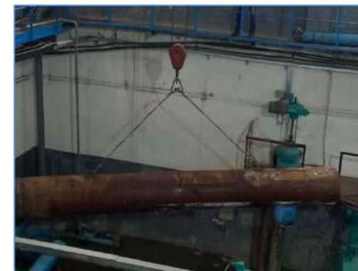
баньводкомплекс» начаты работы по реконструкции напорного коллектора. В настоящее время в машинном зале ведется демонтаж стальных труб, отслуживших свой срок эксплуатации.
