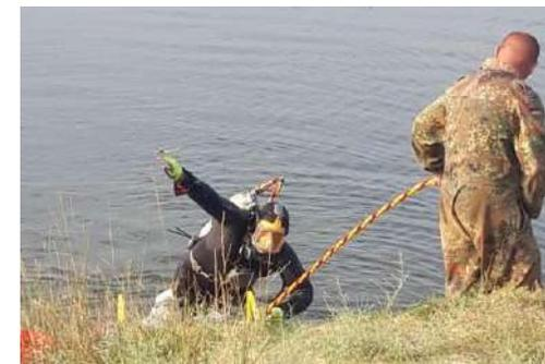
ство работ по установке хомута осложнялось высоким давлением воды в месте повреждения – около 11 атмосфер. Поток воды просто выталкивал водолаза из котлована несмотря на то, что его специально дополнительно огрузили почти на 50 кг. В итоге на время непосредственного выполнения аварийно-восстановительных работ давление воды в трубопроводе пришлось снизить. Действия водолазов координировали специалисты РЭУ «Таманский групповой водопровод».
