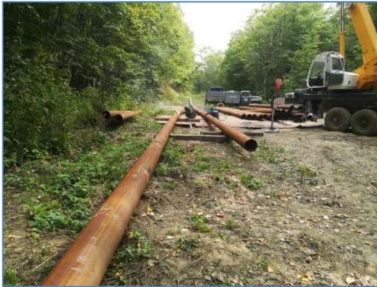
Специалисты РЭУ «Троицкий групповой водопровод» ГУП Краснодарского края «Кубаньводкомплекс» завершили строительство дублирующей нитки магистрального водовода МВ-3 протяженностью 663 метра диаметром 325 мм.
