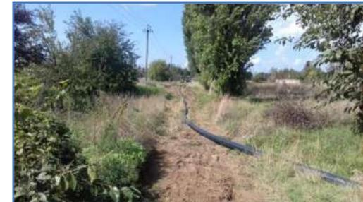
Будет проведена замена старого аварийного водопровода протяженностью 575 метров на новый пластиковый диаметром 160 мм, а также планируется установить вантуз для сбрасывания воздуха из системы водоснабжения во избежание образования воздушных пробок и построить водопроводный колодец», - рассказал Андрей Горячкин, начальник РЭУ «Таманский групповой водопровод» ГУП КК «Кубаньводкомплекс».
