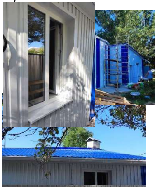
Канализационная насосная станция № 7 после ремонта
