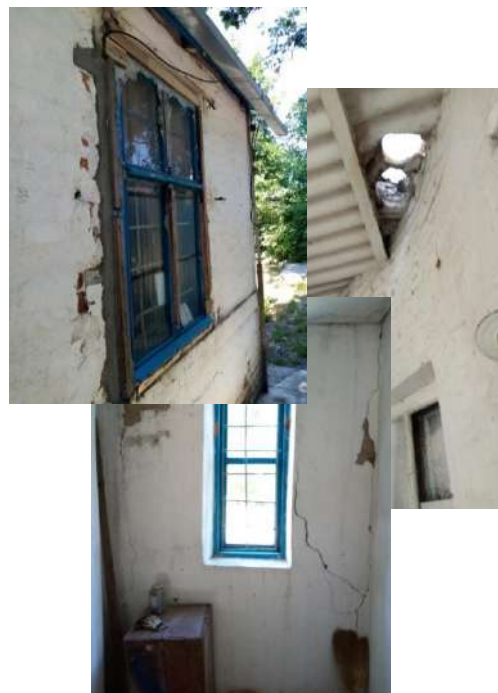
Канализационная насосная станция № 7 до ремонта
