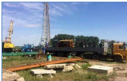
Ремонтные работы на водозаборе продолжаются, в настоящее время ведутся работы по бурению еще двух артезианских скважин глубиной 360 метров.
