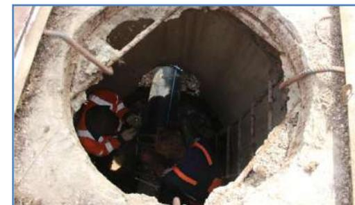
Итого было заменено более одного километра водопроводных сетей. Взамен стальной трубы уложена полимерная со сроком эксплуатации не менее 50 лет диаметром 315 мм.
