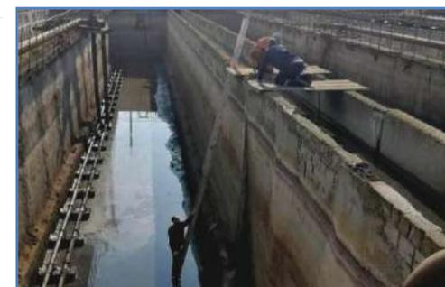
В рамках ремонтных работ будет произведен ремонт бетонного основания секции № 3 аэротенка и переходных мостков, восстановлена герметизация боковых стен, заменены шибберные задвижки. Завершить работы планируется до декабря 2020 года.
