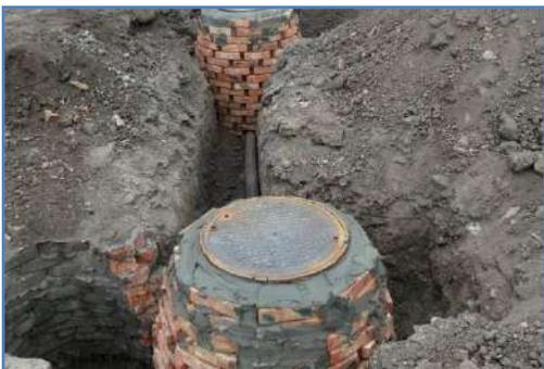
В городе Ейске завершена укладка пластиковой трубы длиной 180 метров, диаметром 225 мм, на участке разводящих
