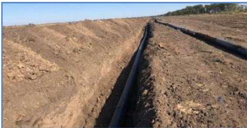
Специалисты РЭУ «Ейский групповой водопровод» ГУП КК «Кубаньводкомплекс» заменили аварийный участок магистрального трубопровода В-2 протяженностью 1120 метров, по которому вода подается в села Кухаривка и Воронцовка, хутор Приазовка Ейского района. Аварийный километровый участок доставлял немало хлопот из-за частых аварий, вследствие чего жители этих населенных пунктов испытывали недостаток в питьевой воде. Только за период с января 2018 года по сентябрь 2019 года здесь было устранено 15 утечек.
