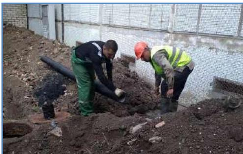
Жителям дома № 266 по улице Морской города Ейска немало неудобств доставлял самотечный коллектор, по которому сточные воды сбрасывались в канализационный коллектор большого диаметра. Как установили специалисты РЭУ «Ейский групповой водопровод» ГУП КК «Кубаньводкомплекс» коллектор был построен с нарушениями, вследствие чего часто забивался. Поэтому аварийная бригада Ейского группового водопровода периодически приезжала на этот объект, с целью устранения засоров.
