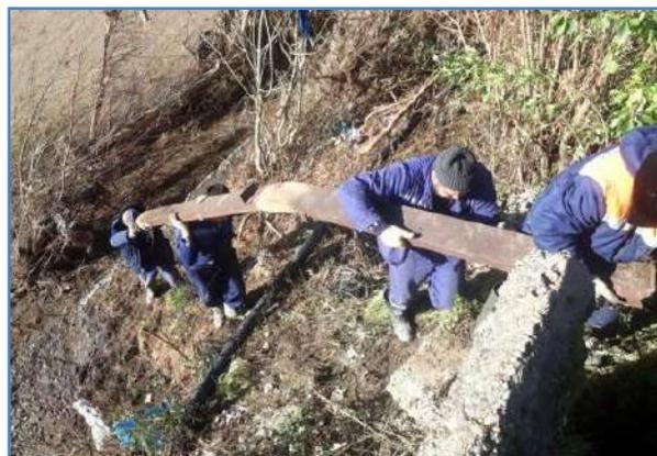
шинные залы и водозаборы. Необходимо было откачать воду и расчистить объекты от ила, веток, поваленных деревьев, камней и обломков горных пород. В селе Кирпичном специалистам еще пришлось восстанавливать разрушенный поток воды участок подвешенного водовода протяженностью 100 метров через реку Туапсе и на артезианской скважине произвести замену насосного агрегата.
