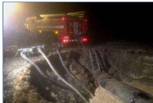
Специалисты работали в напряженном режиме всю ночь, были выполнены земляные работы, откачка воды и в шесть часов утра 14 ноября бригады приступили к сварочным работам. Делалось все возможное для скорейшего устранения аварии и возобновления подачи воды потребителям.
