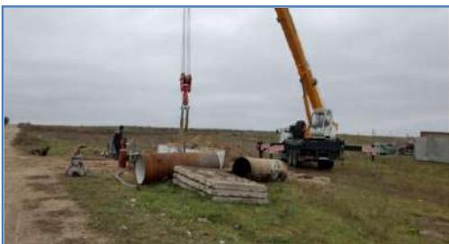
В связи с полной остановкой подачи воды на объектах РЭУ «Троицкий групповой водопровод» одновременно проводился целый комплекс профилактических мероприятий. Среди них устранение двух утечек: крупной на магистральном водоводе МВ-2 диаметром 1220 мм недалеко от станции Троицкой и небольшой на насосной станции четвертого подъема НС-4 в сброс-
