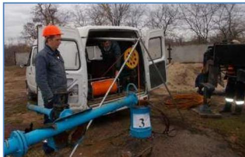
Одновременно с поиском скрытых потерь воды сотрудниками инженерно-технического отдела велись работы и по телевизионной диагностике технического состояния артезианских скважин. Плановое обследование которых позволяет вовремя предотвратить серьезные неисправности системы.
