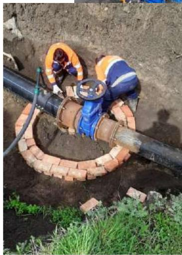
процессе реконструкции трубопровода выполнен монтаж новых водопроводных колодцев,
