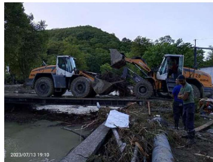
чугунный водопровод диаметром 300 мм через реку Казачка. Со вчерашнего дня специалисты ГУП КК «Кубаньводкомплекс», совместно с работниками МУП «ЖКХ г. Туапсе» приступили к восстановлению разрушенного магистрального водовода. Будет смонтирован новый трубопровод протяженностью 150 м из пластиковых труб, диаметром 300 мм.
