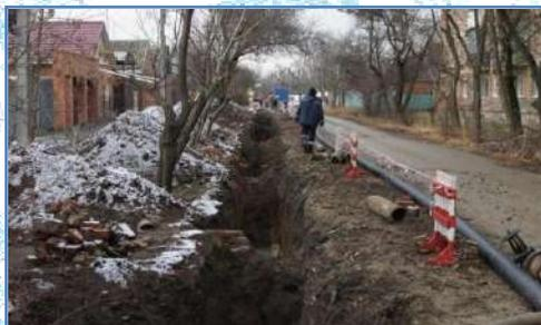
«Металлическая труба на данном участке разводящих водопроводных сетей давно отработала свой ресурс, - рассказывает заместитель начальника РЭУ «Ейский групповой водопровод» Денис Квитовский. - Здесь нередко случались аварии, что вело к большим потерям воды. После укладки новой трубы потерь воды на данном участке из-за аварий и повреждений уже не будет. И мы обеспечим стабильную подачу воды жителям этой части улицы Плеханова».
