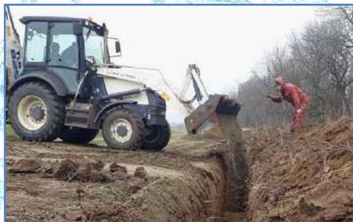
Специалисты РЭУ «Таманский групповой водопровод» ГУП КК «Кубаньводкомплекс» заменили 806 метров подводящего к поселку Стрелка трубопровода диаметром 225 мм и подключили к системе капитально отремонтированный водопровод. Работы проводились в рамках производственной программы. Изношенные асбоцементные трубы были заменены на современные, из долговечного материала – полиэтилена низкого давления.
