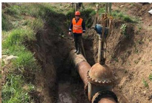
«Кубаньводкомплекс» выполнили работы по установке новой задвижки, диаметром 500 мм, на напорном магистральном водоводе МТ-1. Работы проводились рядом с поселком Юбилейный.
