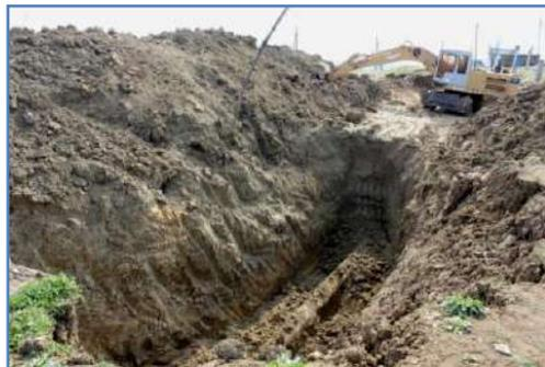
В ходе работ будут заменены подводящие к резервуарам и подающие в сеть внутривоздушные водоводы, выполнены бетонные работы и гидроизоляция самих РЧВ. Необходимость замены водоводов связана с их сильной изношенностью. В настоящее время уже выполнена новая обвязка водоводами диаметром 300 мм и 400 мм РЧВ №3. Заменены участки трубопроводов длиной 7 и 20 метров. Ремонтные работы осложнены большим объемом земляных работ из-за глубины залегания водоводов - более 6 м.
