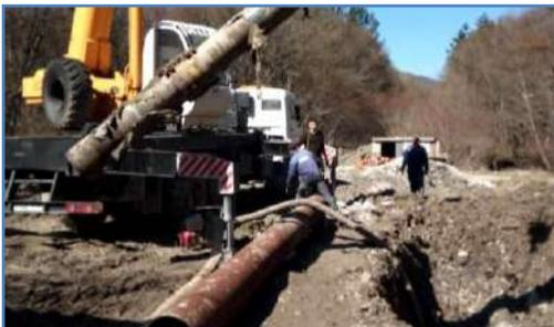
Специалисты РЭУ «Троицкий групповой водопровод» ГУП КК «Кубаньводкомплекс» заменили два аварийных участка на магистральном водоводе МВ-3 диаметром 426 мм, обеспечивающего водоснабжением пос. Верхнебаканский, с. Гайдук и ОАО «Верхнебаканский цементный завод».
