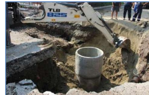
близости водопроводный колодец, который был восстановлен силами работников Ейского группового водопровода. Работы по ремонту канализационного колодца выполнены в полном объеме, произведена обратная обваловка конструкции. Канализация функционирует в штатном режиме. Осталось выполнить работы по восстановлению асфальтобетонного покрытия дорожного полотна.
