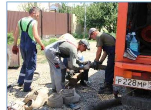
Для очистки канализационных сетей руководством ГУП КК «Кубаньводкомплекс» была направлена канало-промывочная машина. Ликвидация засоров в трубопроводах осуществляется гидродинамическим способом с помощью водяной струи, давление которой достигает до 200 атмосфер.
