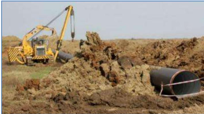
дится между станцией Троицкой и городом Крымском. В последние годы на этом водоводе проводились работы по его частичному ремонту. Магистраль МВ-2 диаметром 1220 мм эксплуатируются на протяжении уже более 30 лет и имеет высокую степень износа. Сегодня система водоснабжения Троицкого группового водопровода эксплуатируется
