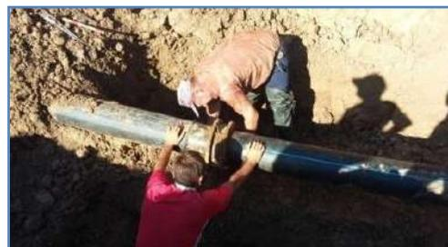
3 августа успешно завершены работы по замене аварийного участка подводящего водовода к поселку Гаркуша Темрюкского района. Проблемный участок водопровода протяженностью 273 м был заменен на новый пластиковый диаметром 225 мм с минимальным сроком эксплуатации 50 лет. Ремонтные работы выполняла бригада
